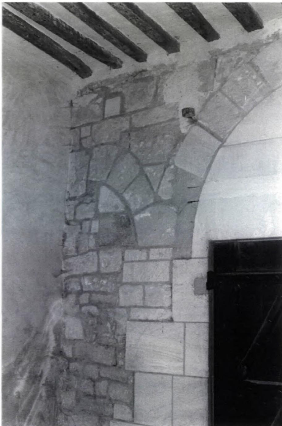
Fig. 76 : façade occidentale, face intérieure, une des ouvertures anciennes en plein cintre, de part et d'autre du porche actuel (13<sup>e</sup> s.)
