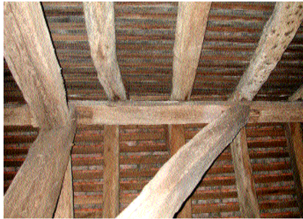
Fig. 10 Décalage dans le réemploi des assemblages
