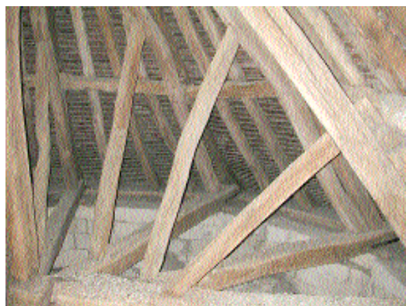
Fig. 7 Demi-fermes avec enrayure de leur entrant supportant les contrefiches.
