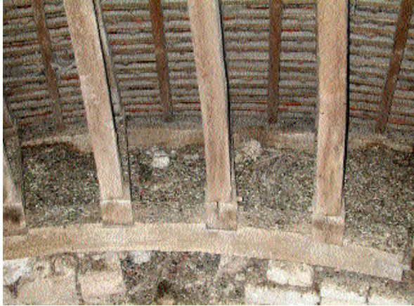
Fig. 16 Pieds des demi-fermes secondaires de la croupe, avec sablières courbes.
