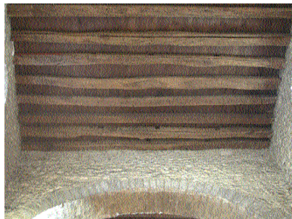
Fig. 4 Vue rapprochée des entrails réemployés. Les deux entrails situés près de l'arc diaphragme sont repositionnés comme dans leur situation initiale.
