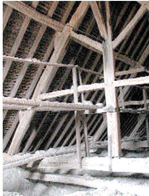
Fig. 11 Ferme de la nef avec tirant en bois sous l'entrait.
