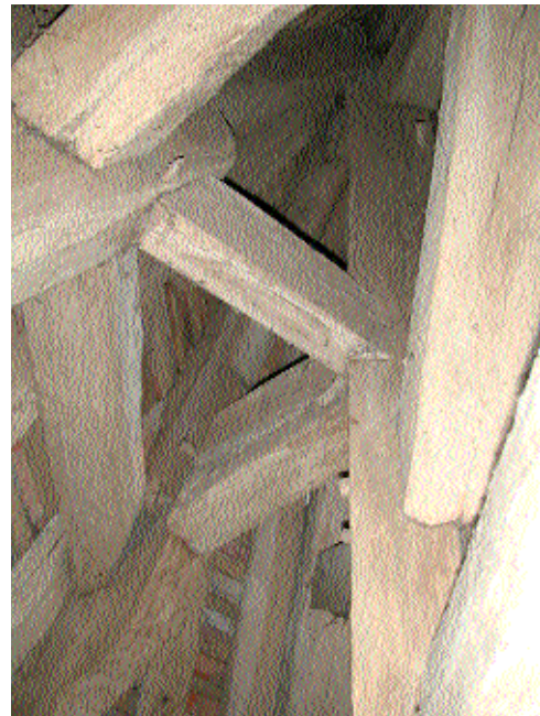
Fig. 11 Vue du dessous de l'enrayure supérieure de la croupe.
