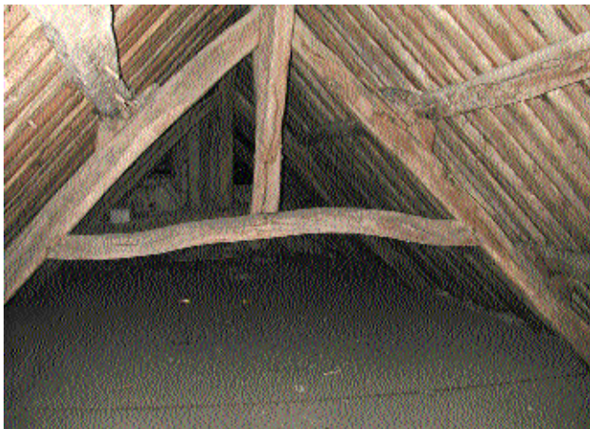
Fig. 3 Charpente de la nef.
