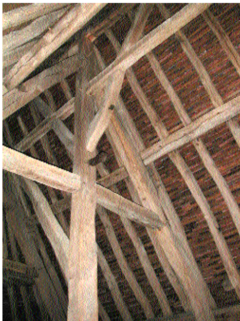
Fig. 3 Ferme de la charpente du choeur.
