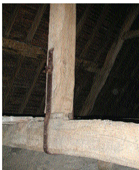
Fig. 24 Etrier métallique du XVIe siècle pour stopper l'ouverture de l'assemblage.
