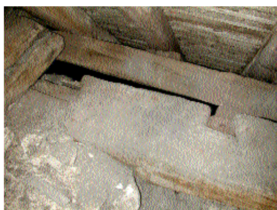
Fig. 12 Vue rapprochée des entailles à mi-bois de l'entrait réemployé.
