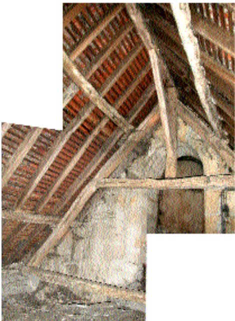
Fig. 14 Charpente du chœur, ferme contre la tour clocher.
