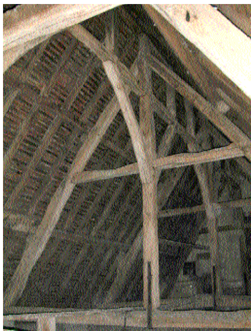
Fig. 21 Charpente du chœur.
