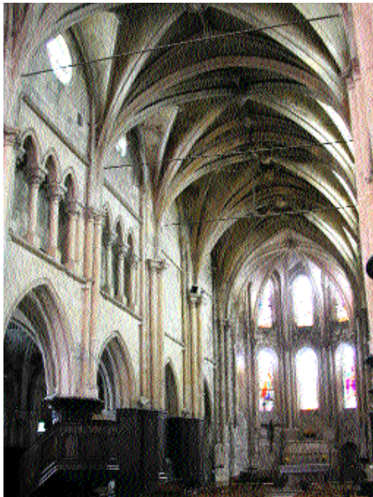
Fig. 3 Elévations à trois niveaux de la nef et à deux niveaux du chœur. Les tirants en métal luttent contre la poussée des voûtes de la Renaissance.
