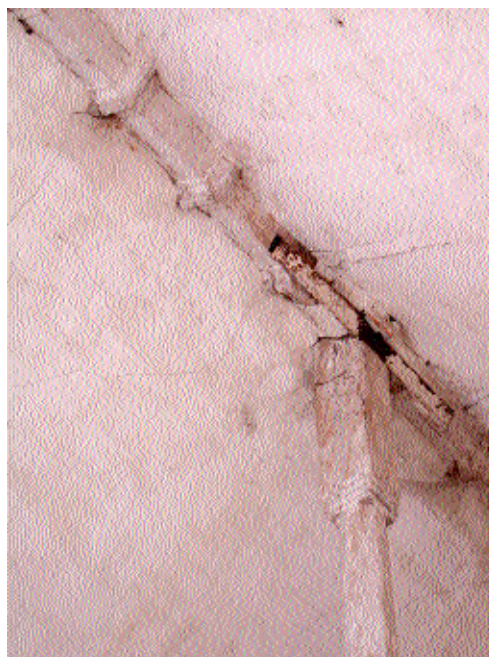
Fig. 4 Vue rapprochée des moulures du poinçon et de la lierne.
