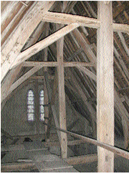
Fig. 9 Charpente du croisillon nord.
