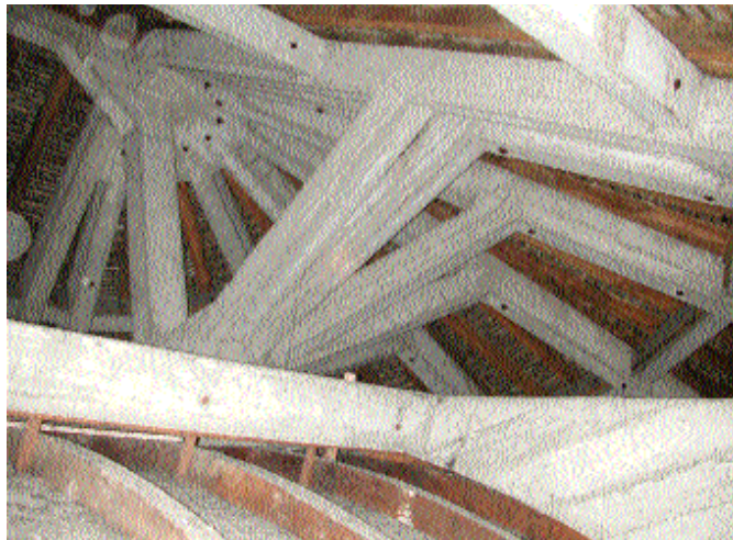
Fig. 16 Parties hautes de la charpente avec vue de l'enrayure des contrefiches de la croupe.
