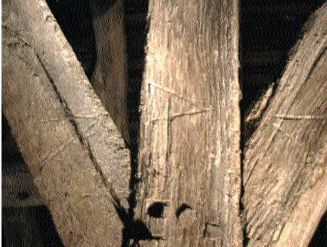
Fig. 14 Marques d'assemblages en V en pied du poinçon et des contrefiches
