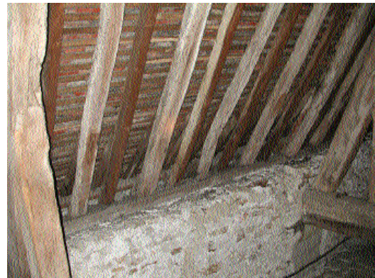
Fig. 12 Chevrons montrant leur mortaise vide pour une ancienne jambe de force.
