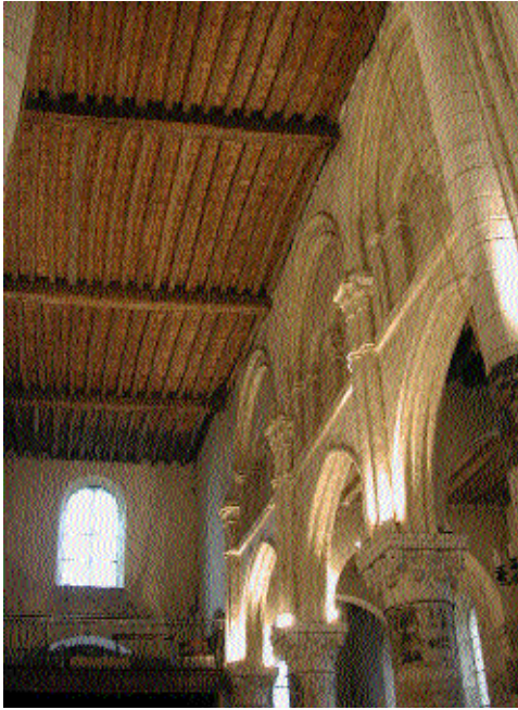
Fig. 1 Vue de la nef avec son plafond apparent.
