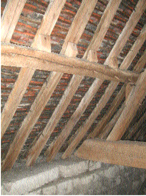
Fig. 5 Fixation des chevrons sur les pannes
