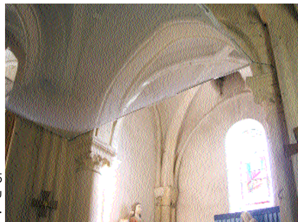
Fig. 5 Croisillon sud du transept.
