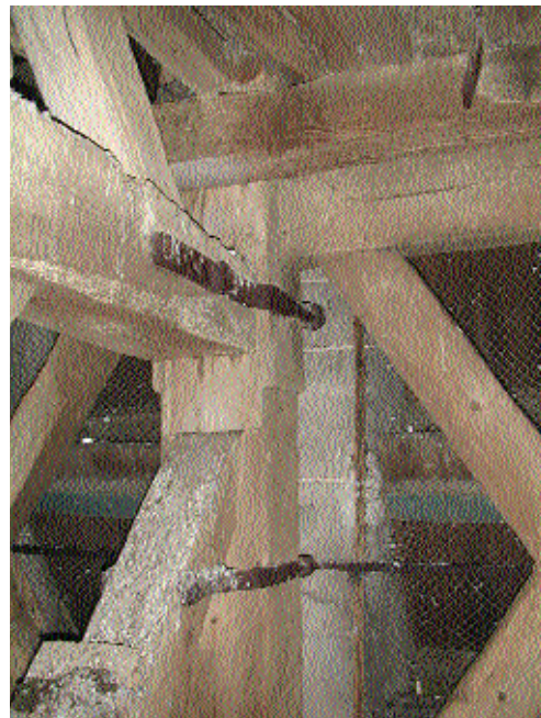
Fig. 29 Assemblages renforcés au métal d'un poteau médian aux éléments du pan transversal.
