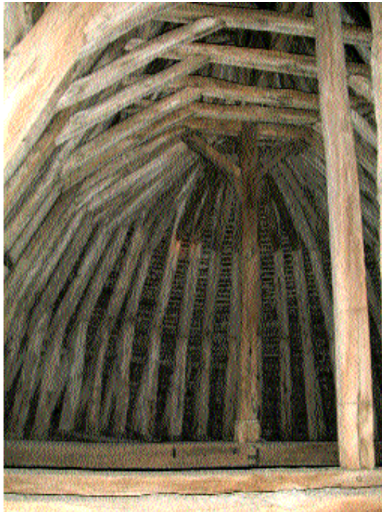
Fig. 1 Charpente du chœur.
