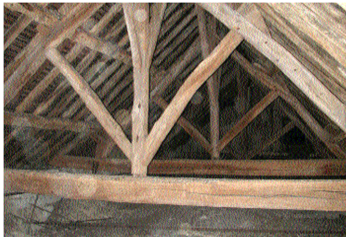
Fig. 8 Charpente de la nef
