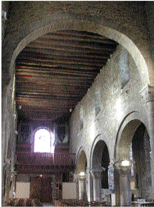
Fig. 1 Nef, avec l'arc diaphragme en premier plan, les grandes arcades surmontées des fenêtres hautes. Le plafond du XIXe siècle s'apparente de très près à celui du XIe siècle.
