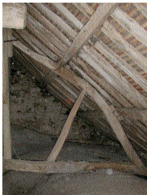
Fig. 18 Charpente du bas-côté nord de la nef.
