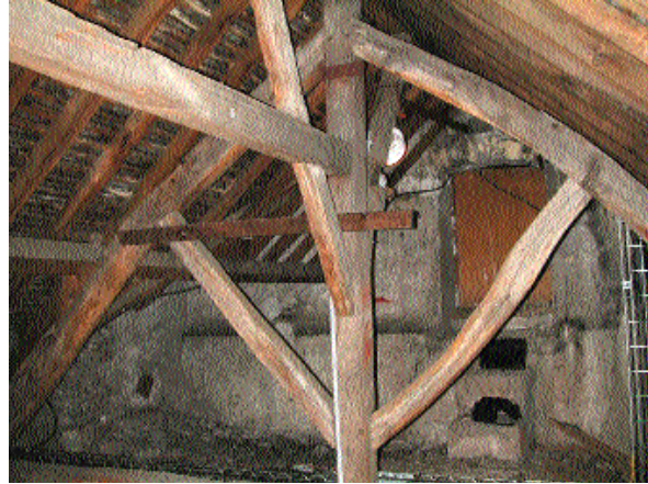
Fig. 11 Charpente à fermes et pannes de la croisée du transept.
