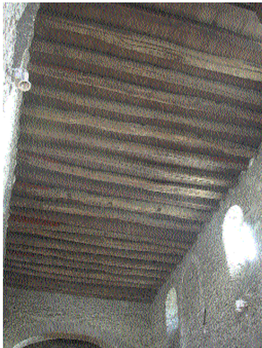
Fig. 4 Vue rapprochée des entrails réemployés. Les deux entrails situés près de l'arc diaphragme sont repositionnés comme dans leur situation initiale.
