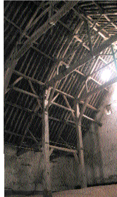
Fig. 3 Charpente de la partie Est
