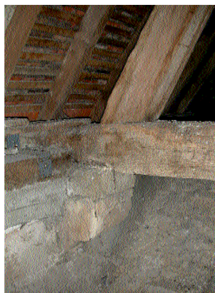
Fig. 22 Chanfrein aux arêtes du poinçon.
