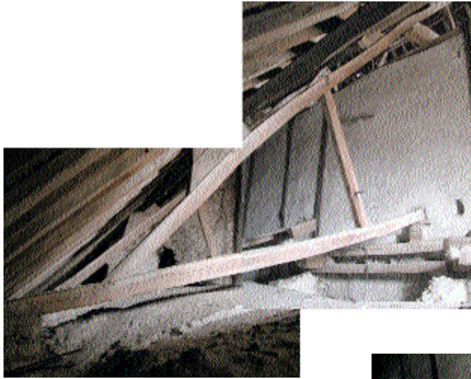
Fig. 2 Chaînage en bois : double cours de longrines moisant un tirant dont on voit l'extrémité bloqué par deux étrépillons.
