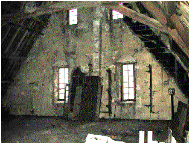
Fig. 6 Mur pignon sud. Tracé du lambris de la voûte
