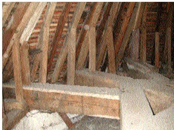
Fig. 10 et 11 Enrayure basse et haute de la croupe.
