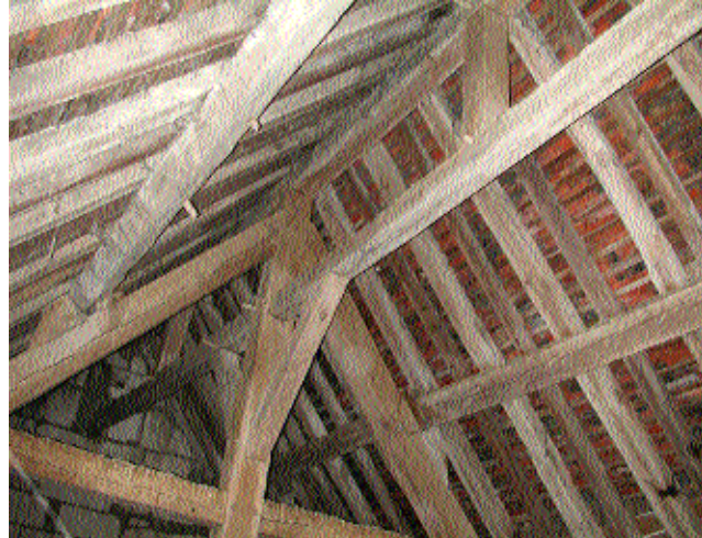
Fig. 7 Etrésillonnement longitudinal des fermes du transept.
