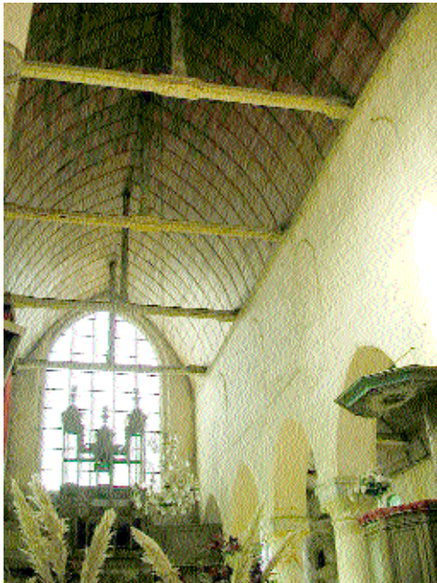
Fig. 3 Charpente voûtée et lambrissée de la nef.
