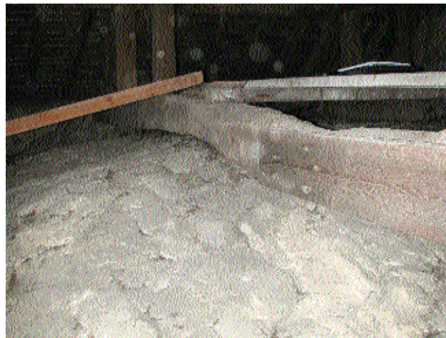
Fig. 15 Entrait de la ferme s'appuyant sur les voûtes .
