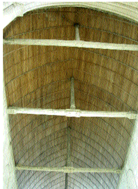
Fig. 4 Fermes de la charpente de la nef.
