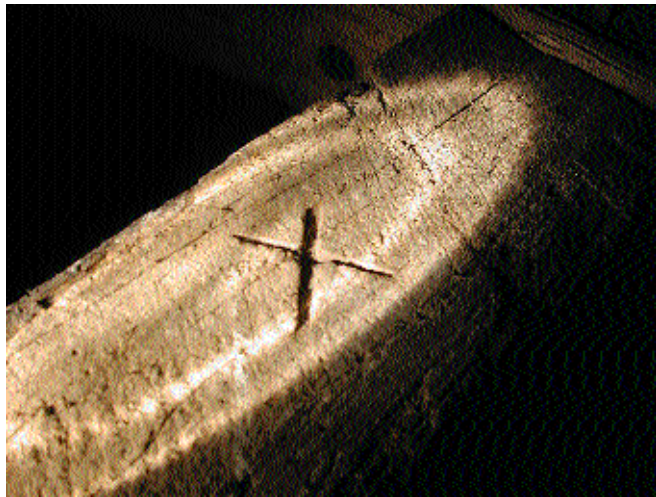
Fig. 15 Marque d'assemblage en croix taillée au ciseau
