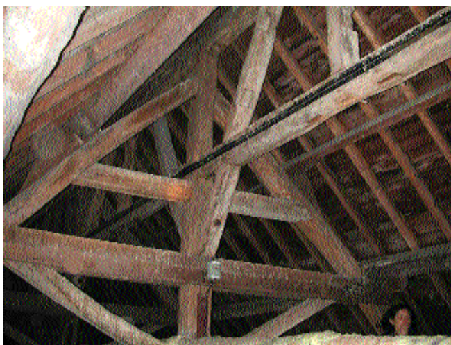
Fig. 9 Partie haute du comble
