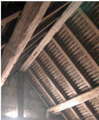
Fig. 13 Mortaise vide dans la panne faîtière pour le lien d'une ferme disparue.
