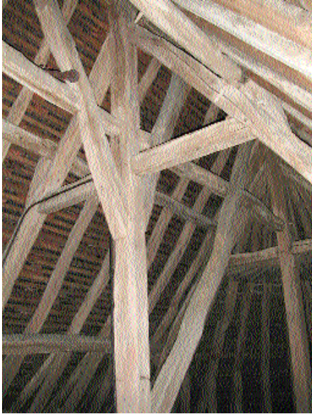
Fig. 6 Ferme de la charpente de la chapelle latérale sud.
