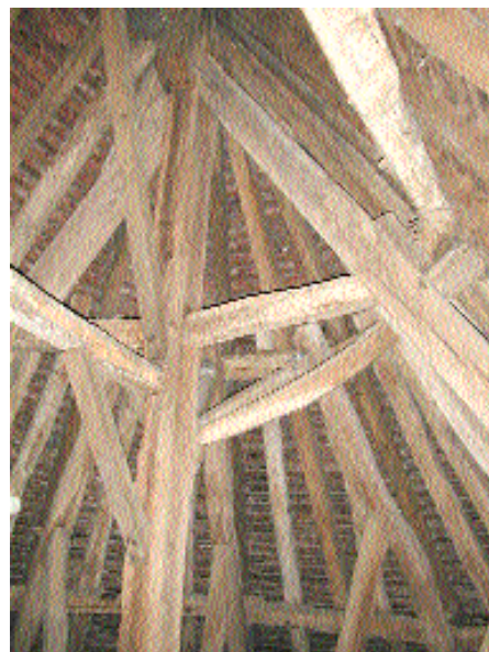
Fig. 6 Partie haute de la croupe avec vue de l'arrêt des arbalétriers des demi-fermes.
