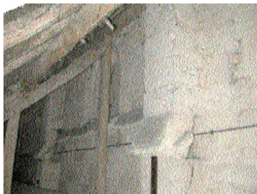
Fig. 2 Comble du bas-côté nord, avec les contreforts percés au niveau de l'ancien solin de toiture.
