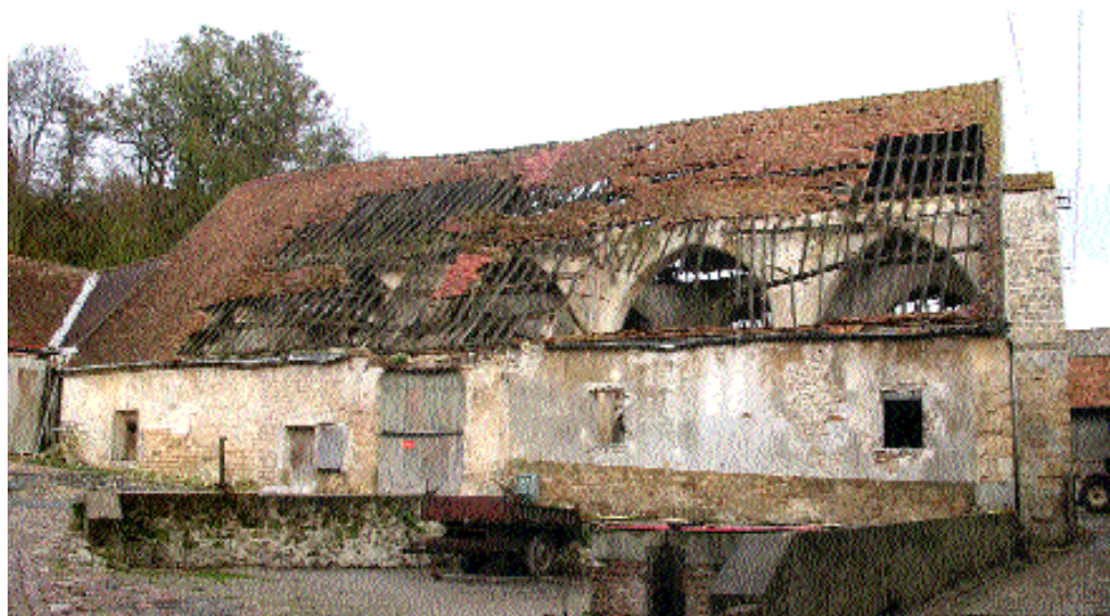
Fig. 1 Vue de la grange versant ouest
