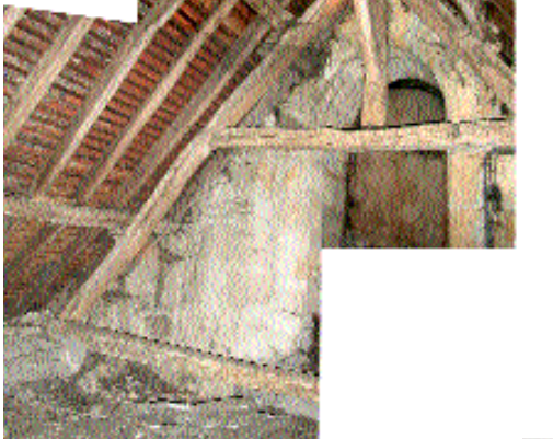
Fig. 15 Ferme de croupe avec vue de la croupe.
