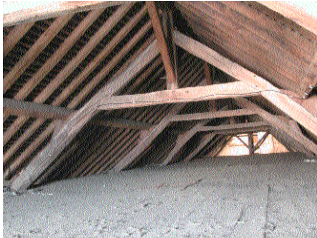
Fig. 6 Charpente à fermes et pannes de la nef, avec son plancher recouvrant les entrains du plafond apparent.
