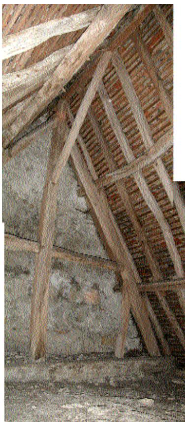
Fig. 5 Charpente de la nef, ferme contre le pignon occidental.
