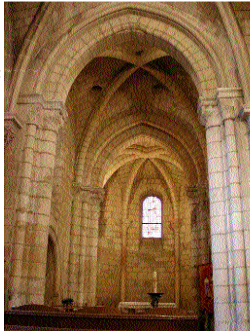
Fig. 2 Chapelle latérale nord du milieu du XIIe siècle.
