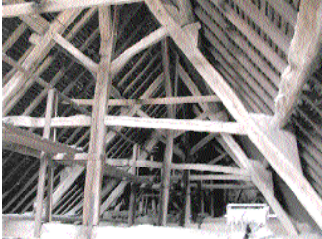
Fig. 12 Partie haute de ferme : lien de contreventement.
