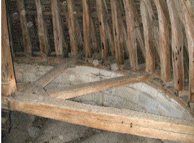
Fig. 5 Enrayure des entrails des demi-fermes de la croupe, avec des goussets pour l'assemblage des entrails des demi-fermes latérales.
