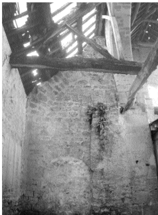
Fig. 3 Mur de refend dans le bas-côté Est. Passage muré et maçonneries en arc de décharge
