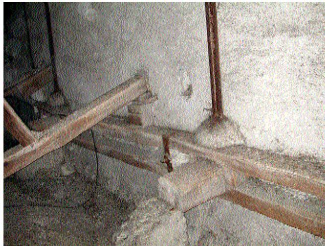
Fig. 2 Chaînage en bois : double cours de longrines moisant un tirant dont on voit l'extrémité bloqué par deux étrépillons.
