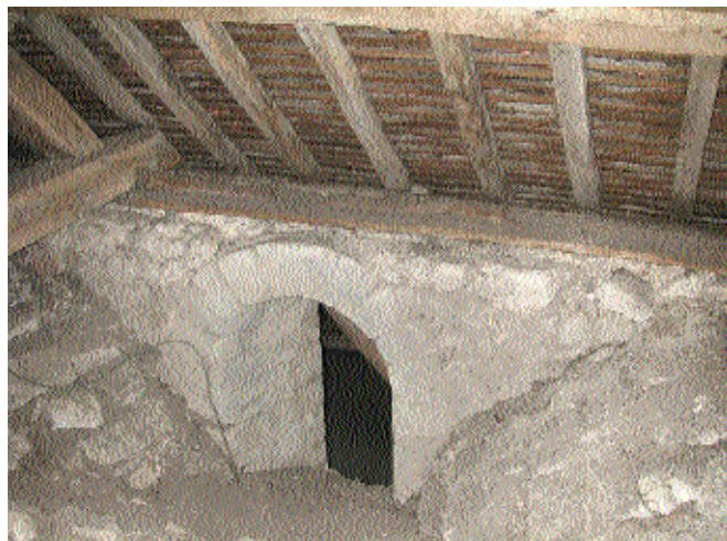
Fig. 7 Baie du XIe siècle prise dans les voûtes rajoutées au XIIe siècle, avec la sablière en place sur le mur.
