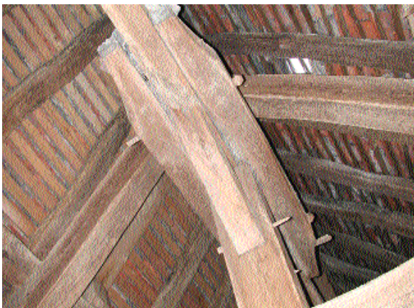
Fig. 4 Moises chevillées dans le cours des sous-faîtières
