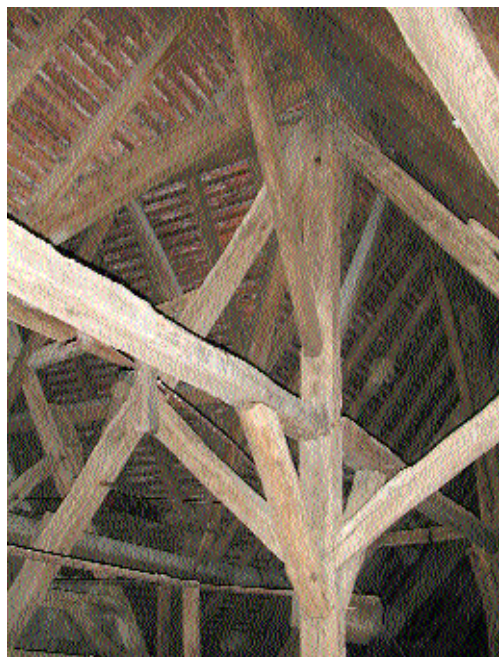
Fig. 5 Sous-faîtage de la charpente du choeur.
