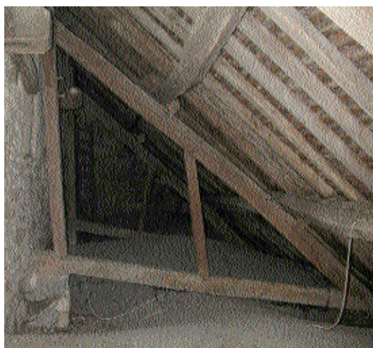
Fig. 19 Charpente du bas-côté sud.
