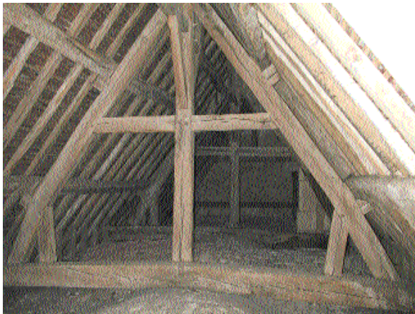
Fig. 3 Charpente de la nef
