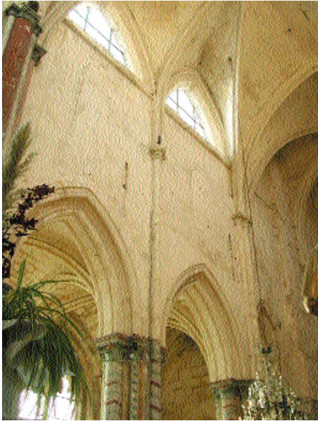
Fig. 9 Elévations sud du chœur. Mes baies médianes sont bouchées et les baies hautes ont perdues leur réseau.
