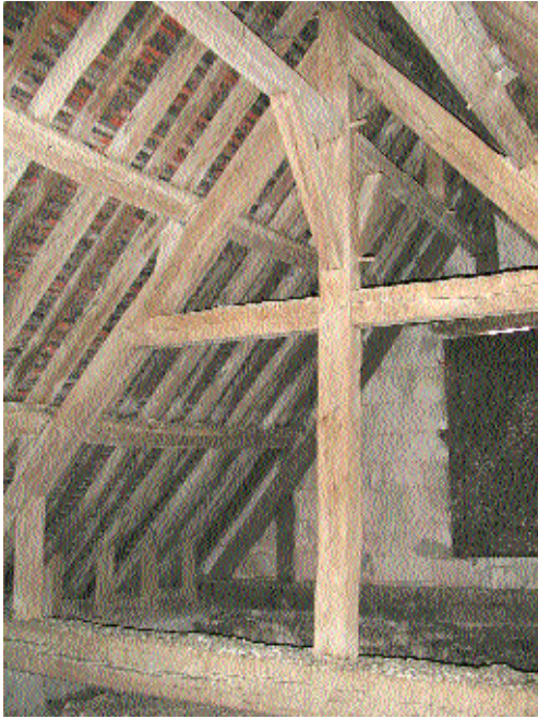
Fig. 6 Charpente du transept.
