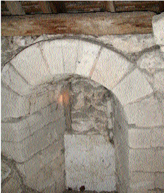
Fig. 15 Montants en bois conservés dans le comblement de la baie.
