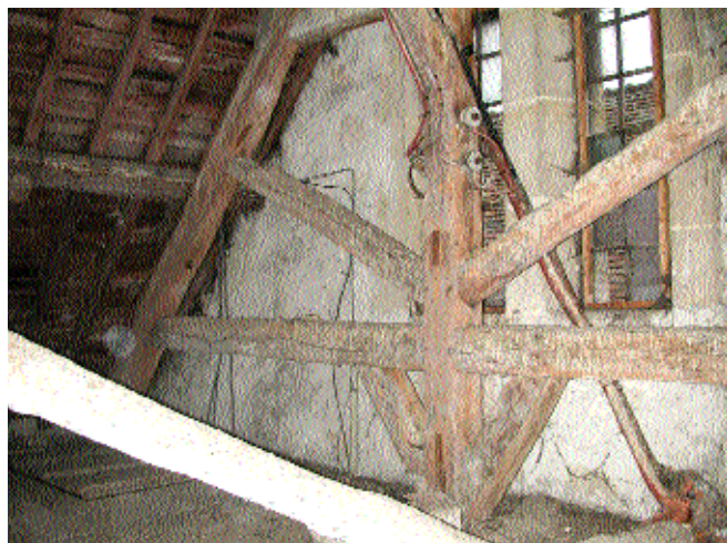
Fig. 8 Ferme du comble des cuisines
