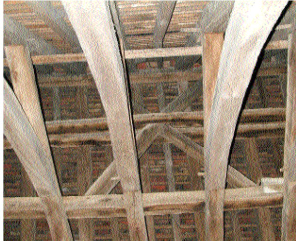
Fig. 12 Croix de Saint André entre la faîtière et la sous-faîtière, prise par deux moises.
