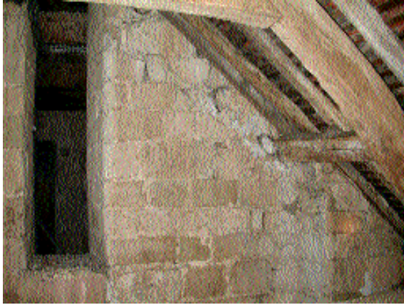
Fig. 13 Traces du solin de toiture de la charpente romane, inclinée à 35°, dans le mur de la tour-clocher.
