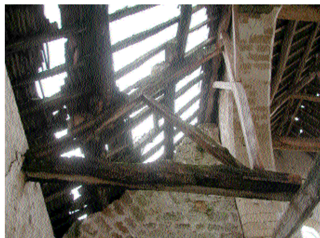
Fig. 7 Demi-ferme du bas-côté Est.
