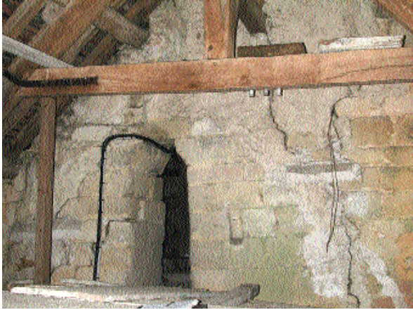
Fig. 6 Traces des solins de la toiture primitive du choeur contre le mur Est de la tour- clocher.
