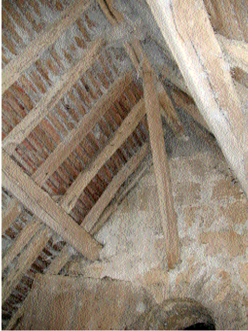
Fig. 12 Charpente du bas-côté nord.
