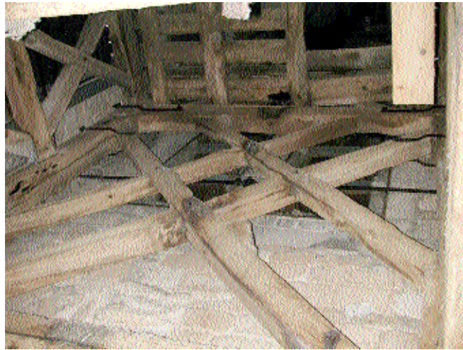
Fig. 27 Pan latéral ouest vue du dessous avec ses couples d'écharpes entrecroisées.
