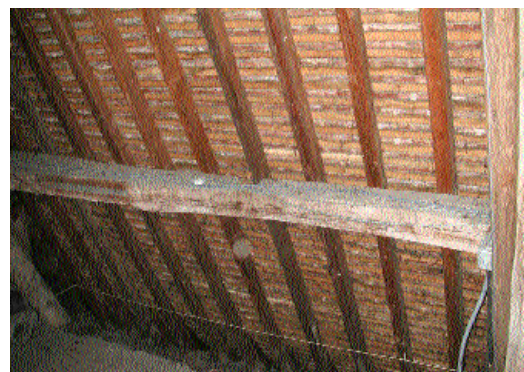
Fig. 3 Réemploi en panne d'un ancien chevron délardé de ferme secondaire
