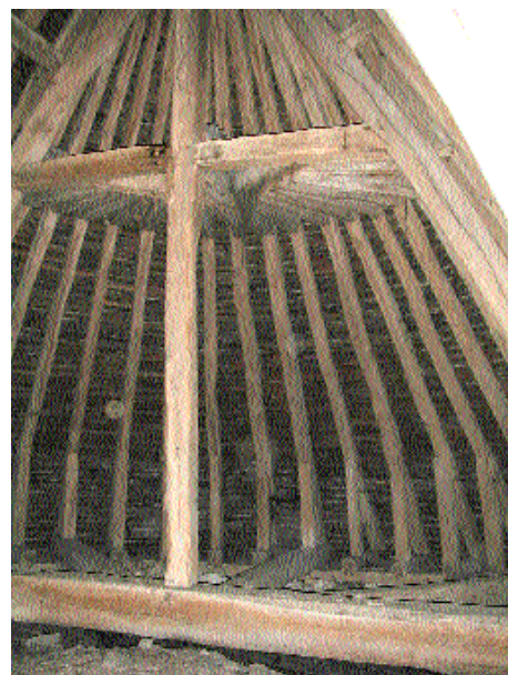
Fig. 4 Croupe à chevrons-formant-fermes de la charpente du choeur.
