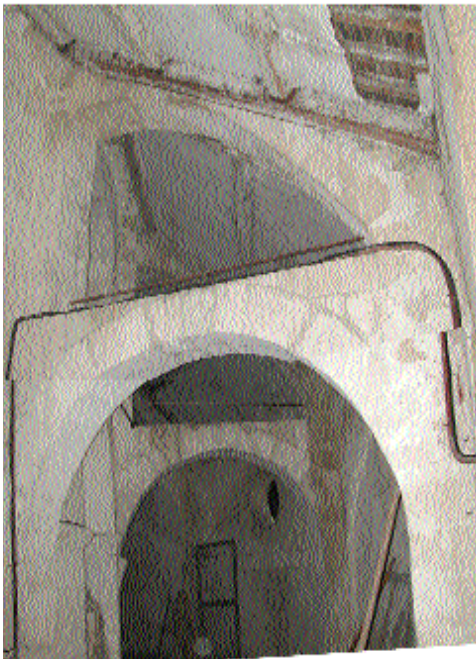
Fig. 9 Arcade en plein cintre de la tribune surmontée de la première volée de l'arc-boutant.
