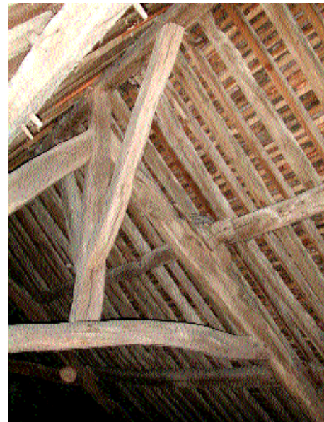
Fig. 4 Partie haute d'une ferme.
