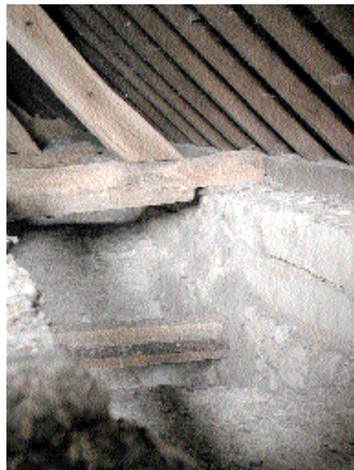
Fig. 14 Entaille vide sous l'entrait pour une sablière disposée à l'origine à l'aplomb du mur. Départ d'un tirant en bois sous la ferme.
