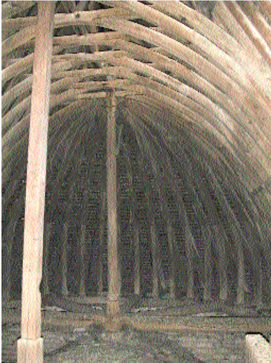
Fig. 11 Charpente du chœur.
