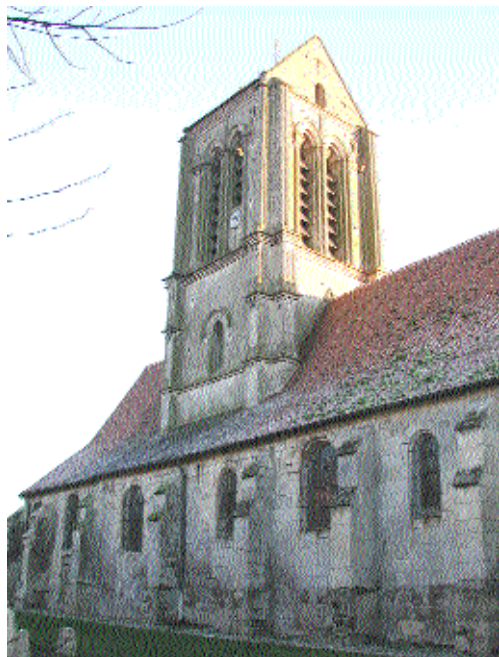
Fig. 1 Elévations nord de l'église.
