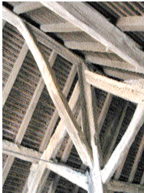
Fig. 13 Mortaise vide dans la panne faîtière pour le lien d'une ferme disparue.
