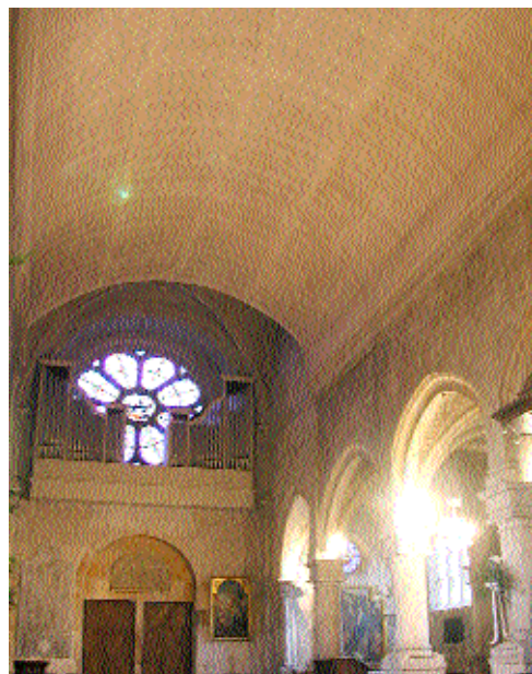
Fig. 10 Nef voûtée en plâtre du XVIe siècle.
