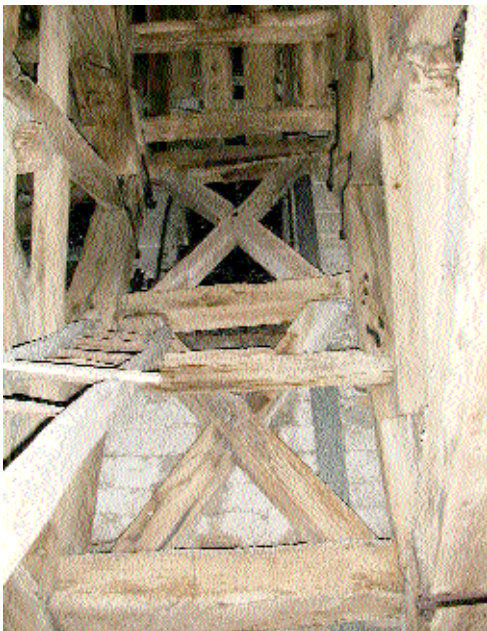
Fig. 28 Pan latéral sud avec ses croix de Saint André assemblées aux traverses.
