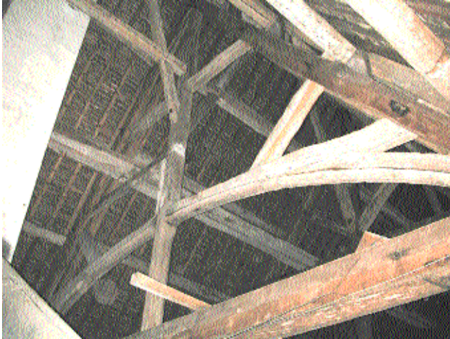
Fig. 4 Partie haute d'une ferme voûtée
