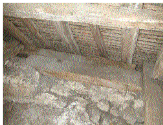
Fig. 11 Entrait roman réemployé en sablière.
