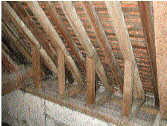
Fig. 8 Pied de chevrons avec jambe de force et blochet.
