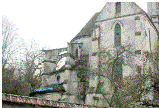
Fig. 10 Vue du chevet avec la deuxième volée des arcs-boutants surmontants les tribunes.
