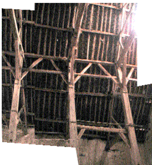
Fig. 4 Contreventement des poteaux de la partie orientale.
