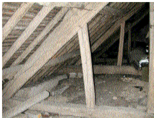
Fig. 3 Charpente du bas-côté nord.
