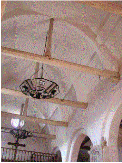
Fig. 1 Charpente de la nef.
