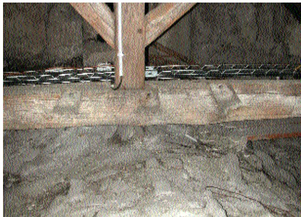
Fig. 13 Vue rapprochée des entailles à mi-bois. L'entaille centrale était destinée à un poinçon, et les deux entailles latérales à des pièces obliques (écharpes ?).
