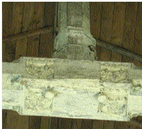
Fig. 5 Moulures et sculptures sur les entrails et les poinçons.
