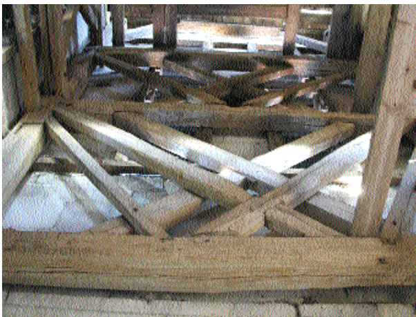
Fig. 12 Pan latéral Est vu du dessous, avec ses trois niveaux raidis par une croix de Saint André. Les autres écharpes sont plus tardives.
