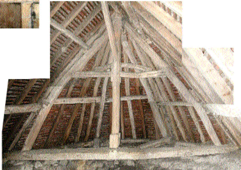
Fig. 15 Ferme de croupe avec vue de la croupe.
