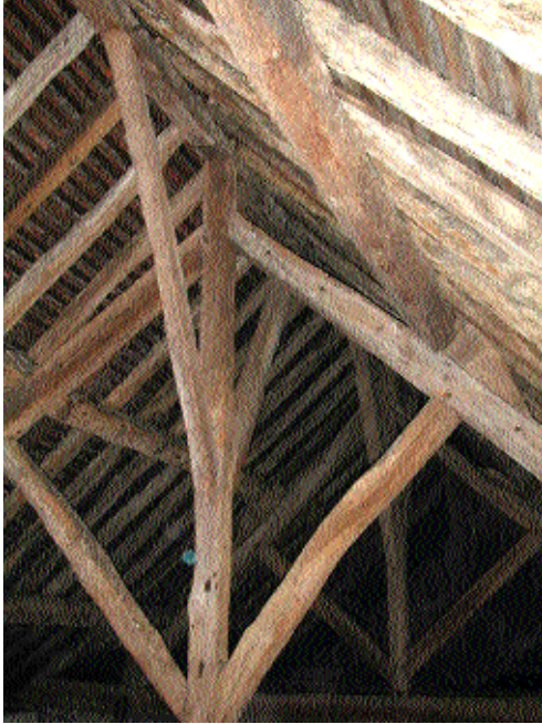
Fig. 9 Partie haute des fermes
