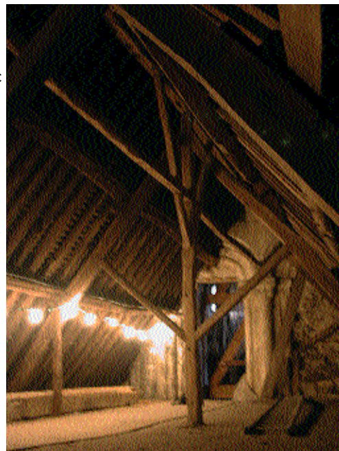
Fig. 14 Charpente des travées de la nef Renaissance.
