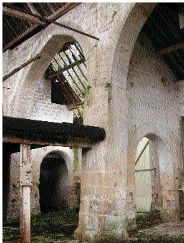
Fig. 2 Piliers, grandes arcades et murs de refend des bas-côtés ouverts de passages latéraux
