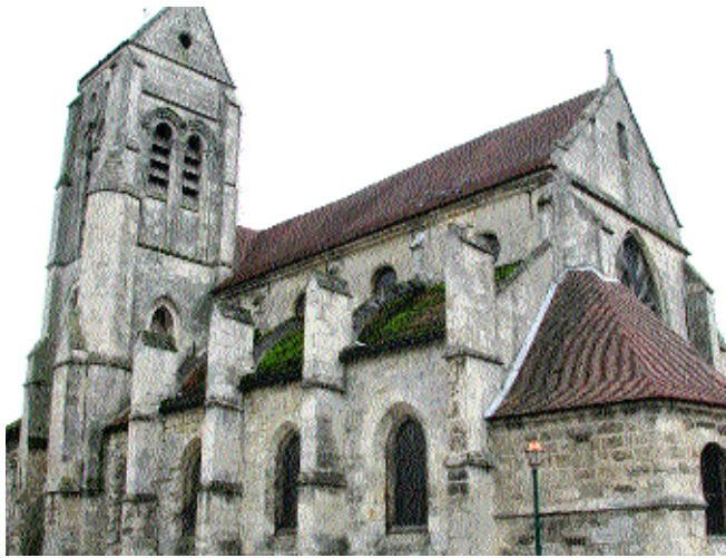
Fig. 1 Nef, bas-côtés nord et tour clocher. Voir les arcs-boutants du XVe siècle responsables du dévers des murs.
