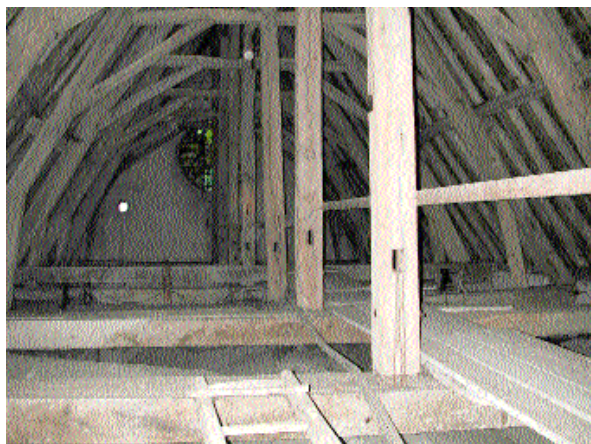
Fig. 13 Charpente de la nef.
