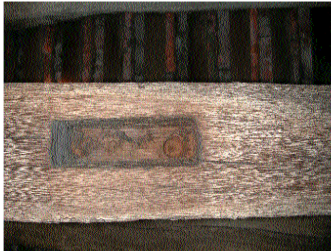
Fig. 18 Traces de percement à la tarière en fond de mortaise, et tracés de piquage à la pointe métallique au droit de l'assemblage
