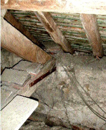
Fig. 13 Ferrures du début du XXe siècle pour consolider les jours des assemblages.
