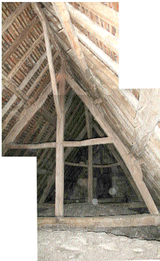
Fig. 6 Fermes de la charpente de la nef, situées de part et d'autre des voûtes.
