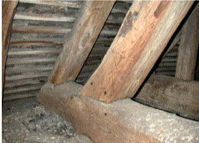
Fig. 16 Pieds de chevron et d'arbalétrier dans l'entrait. On distingue la marque V sur l'arbalétrier et le chevron.
