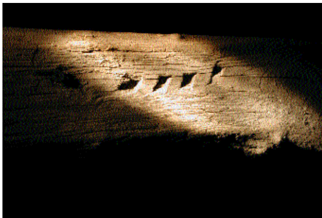
Fig. 17 Marque à encoches taillée au ciseau.
