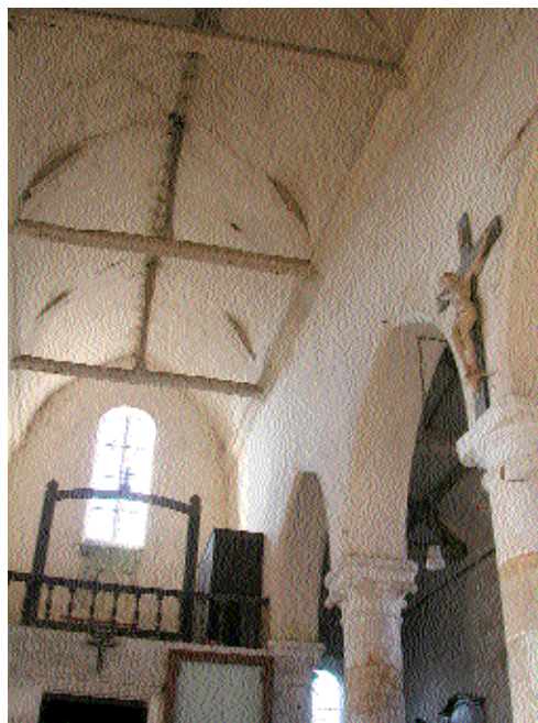
Fig. 3 Ferme de la charpente de la nef.
