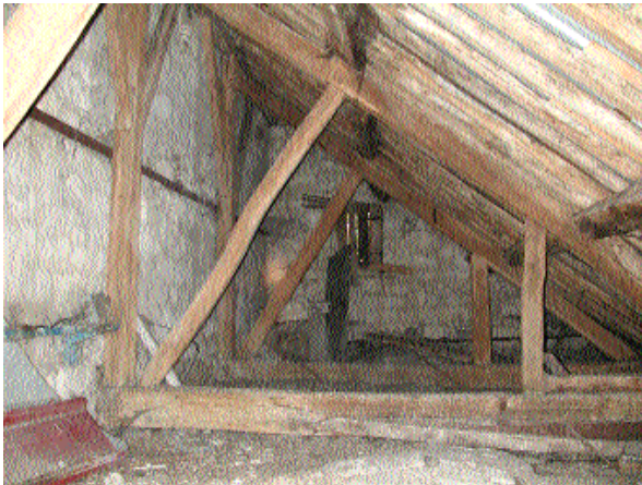
Fig. 2 Charpente du bas-côté sud du choeur
