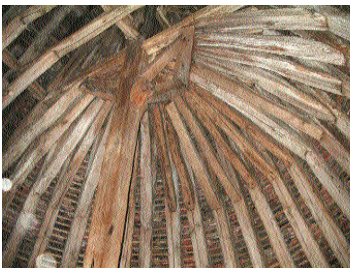
Fig. 4 Enrayure rayonnante des entraits retroussés et des aiseliers des demi-fermes de la croque. Des liens obliques de soutien, assemblés au poinçon, supportent le centre de l'enrayure.
