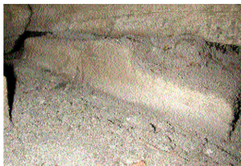
Fig. 12 Vue rapprochée des entailles à mi-bois de l'entrait réemployé.
