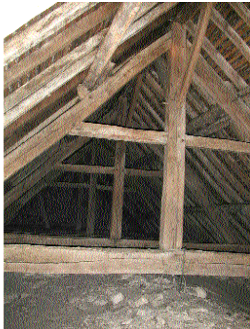
Fig. 16 Ferme de la charpente de la nef.
