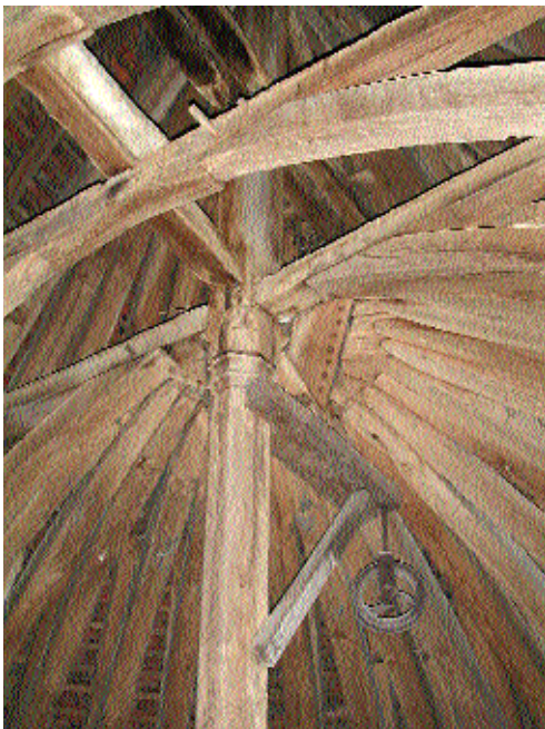
Fig. 14 Enrayure de la croupe avec sculpture du poinçon .
