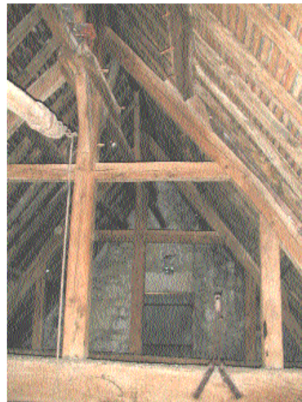
Fig. 3 Charpente du choeur
