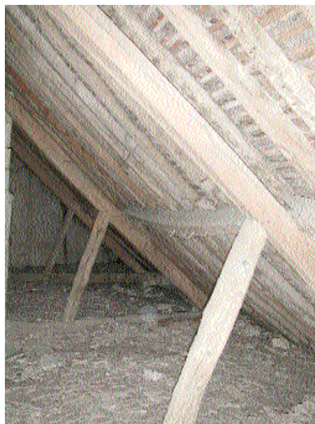
Fig. 4 Charpente du bas-côté sud, avec ses pannes fléchies.
