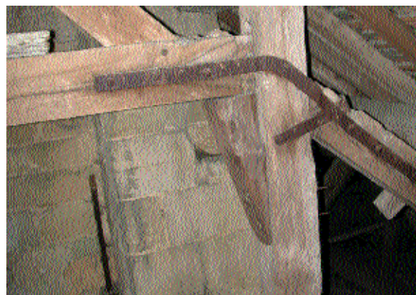
Fig. 13 Ferrures du début du XXe siècle pour consolider les jours des assemblages.
