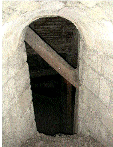
Fig. 14 Rainure et trous creusés sur les flancs de l'embrasure pour la fermeture de la baie.
