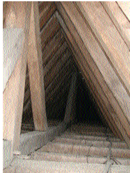
Fig. 7 Partie haute des fermes. Liernes longitudinales et liens de contreventement.
