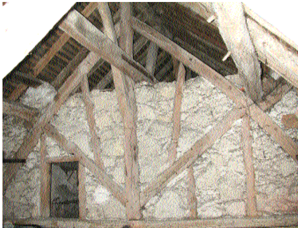
Fig. 3 Ferme du choeur avec sa cloison de plâtre.
