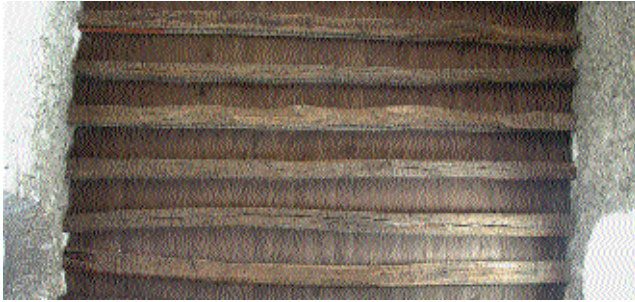
Fig. 6 Charpente à fermes et pannes de la nef, avec son plancher recouvrant les entrains du plafond apparent.
