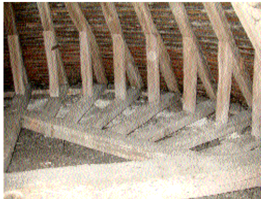
Fig. 8 Croupe de la chapelle sud. Enrayure des entraits et des blochets de la base de la croupe.
