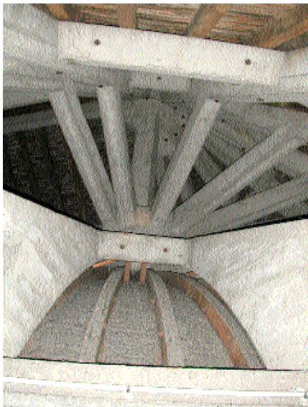
Fig. 17 Vue prise depuis la croupe. Les arceaux de la voûte sont retenues aux arcs en béton.
