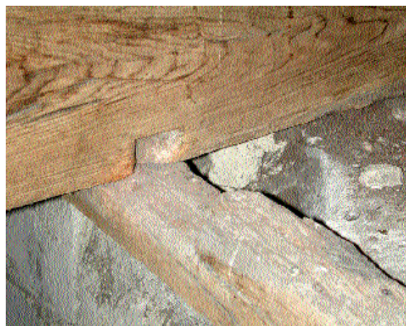
Fig. 13 Encoche latérale taillée dans le flanc de l'entrait destinée au mi-bois de la sablière.
