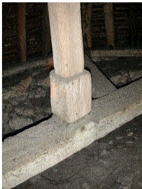
Fig. 18 Pied du poinçon de la ferme de croupe.
