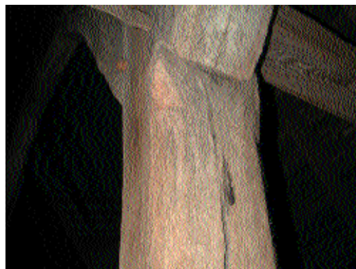
Fig. 22 Chanfrein aux arêtes du poinçon.
