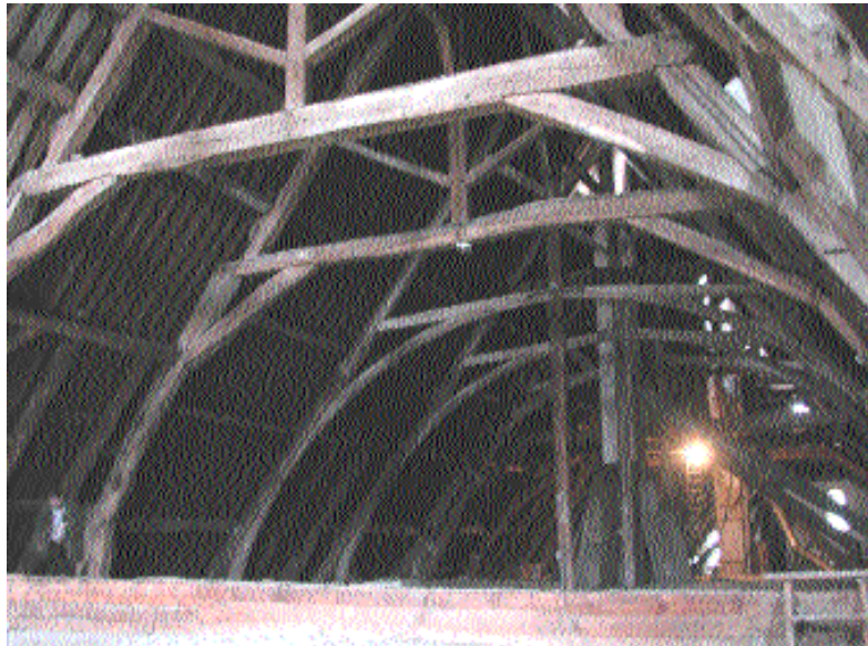
Fig. 1 Charpente du bâtiment des convers avec vue des fermes primitives voûtées
