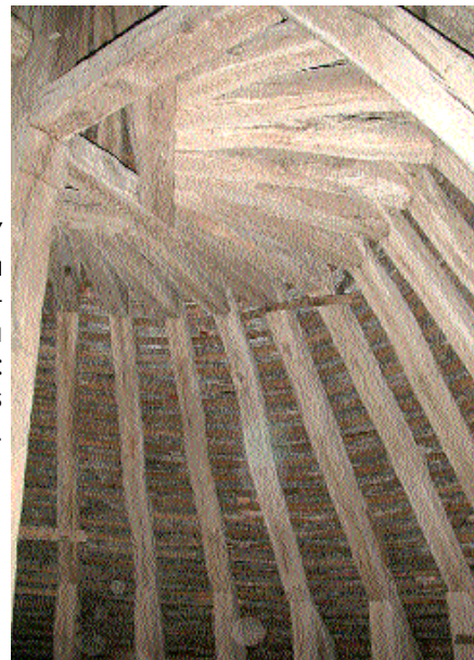
Fig. 7 Croupe à chevrons-formant- fermes de la chapelle sud : enrayure des entraits retroussés.
