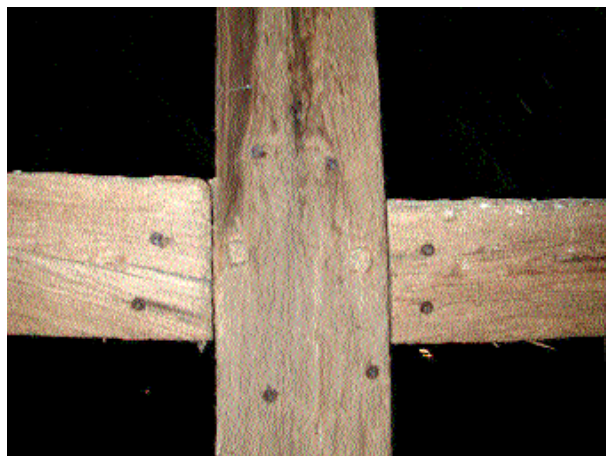
Fig. 18 Piqures d'injections fongicides des bois.
