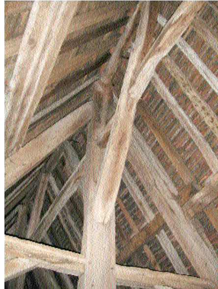
Fig. 10 Partie haute des fermes. Faîtière, sous-faîtière et liens obliques de contreventement.
