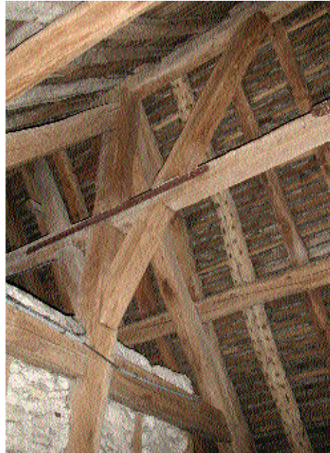
Fig. 6 Charpente du croisillon sud, étrésillonnement longitudinal
