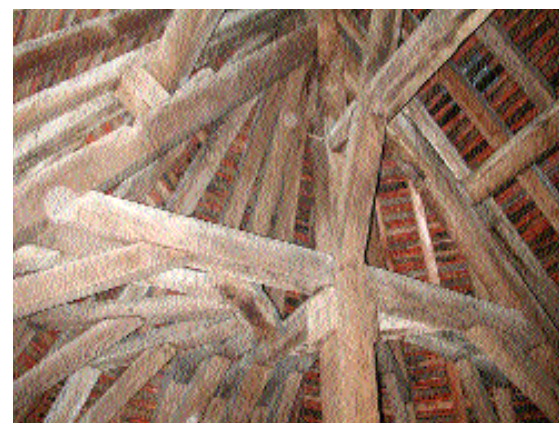
Fig. 10 et 11 Enrayure basse et haute de la croupe.
