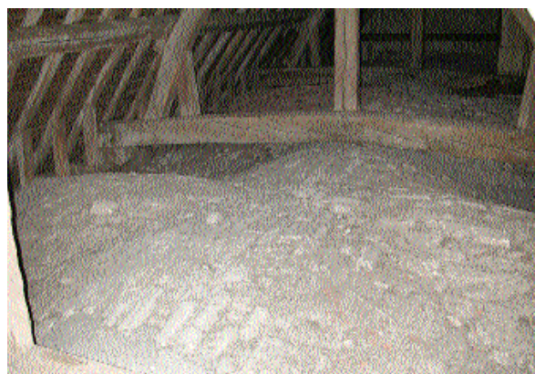
Fig. 5 Pénétration des voûtes dans le comble. Voir la courbure naturelle de l'entrait et sa surélévation par des cales posées sur le mur pour enjamber les voûtes.
