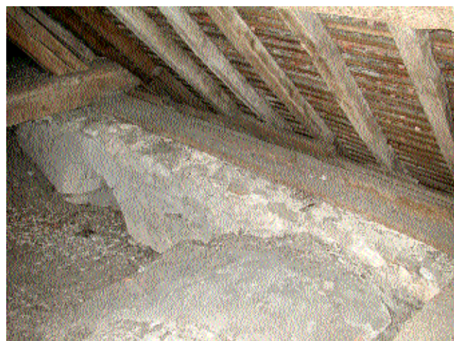
Fig. 9 Vue de la sablière du XIe siècle en place sur le mur roman.
