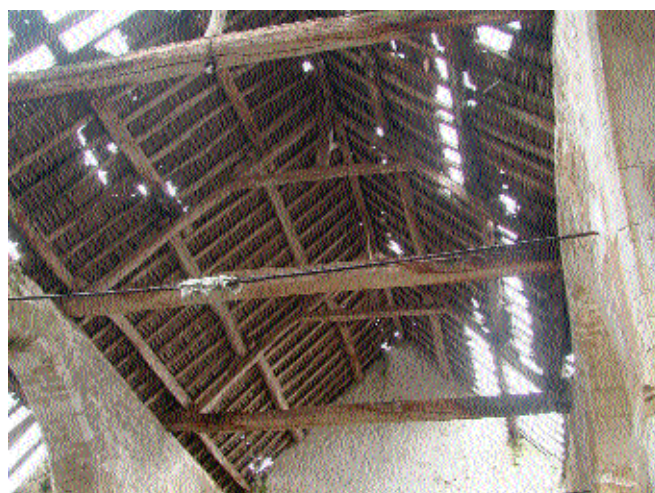
Fig. 6 Ferme à poinçon haut sur la partie sud de la grange
