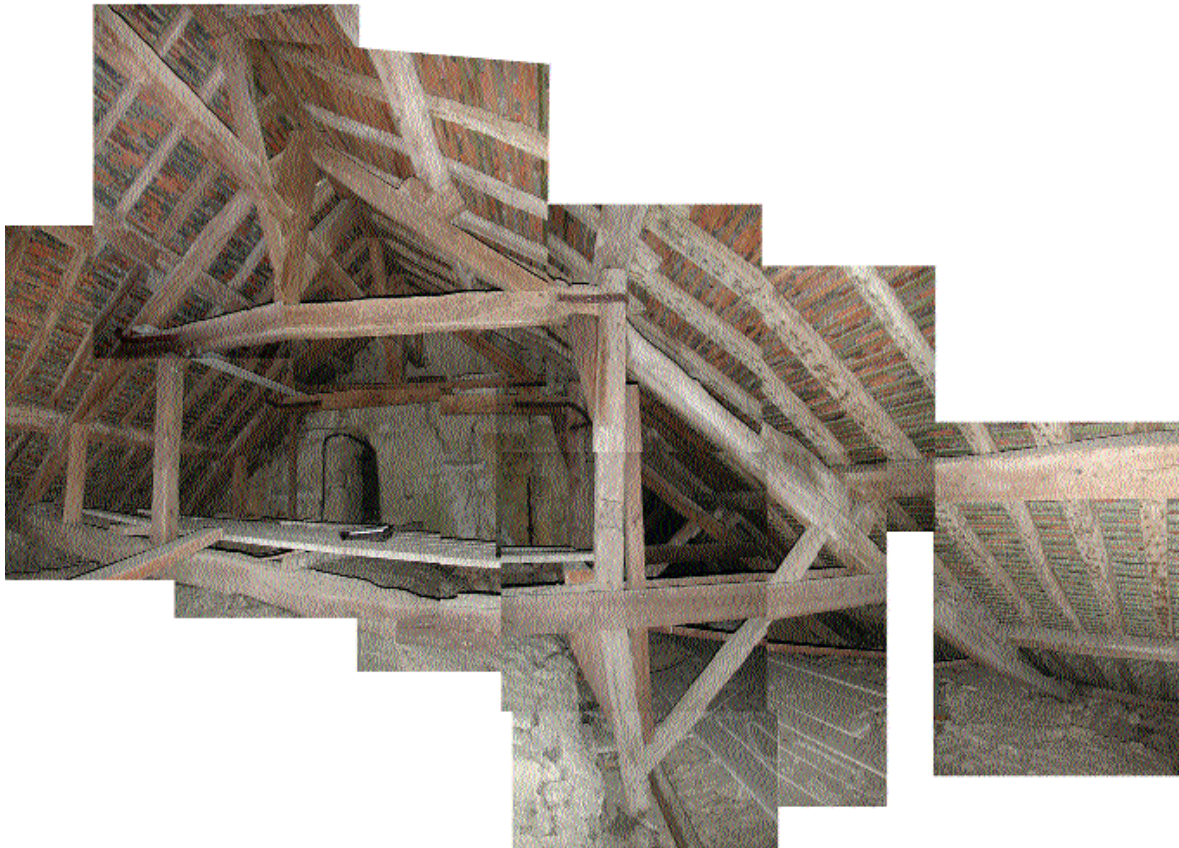
Fig. 7 Vue générale de la charpente du choeur et de la chapelle nord (à droite sur la photo). En premier plan, portique de la ferme Est du choeur, avec le poteau en réemploi, aujourd'hui brisé et maintenu à la demi-ferme de l'appentis par des bastaings en moises.
