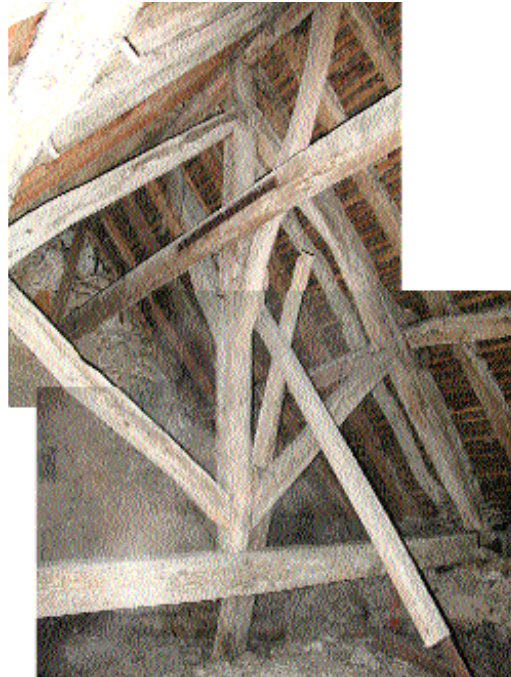
Fig. 3 Ferme du choeur avec sa cloison de plâtre.
