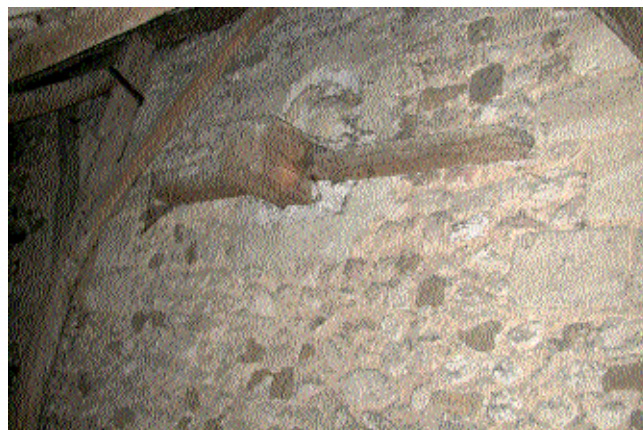
Fig. 17 Extrémité d'un tirant retenu par une traverse en appui contre le mur, au travers d'un oculus du XIIe siècle.
