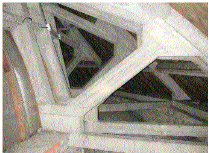
Fig. 18 Charpente couvrant le déambulatoire.
