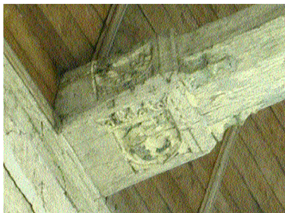
Fig. 5 Moulures et sculptures sur les entrails et les poinçons.
