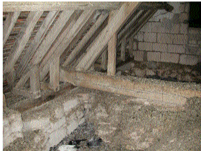
Fig. 8 Pieds de fermes. Les murs gouttereaux sont élevés au-dessus de l'extrados des voûtes.
