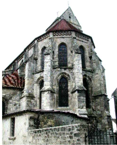
Fig. 2 Choeur à deux niveaux, avec passage extérieur devant les fenêtres hautes au travers des contreforts.
