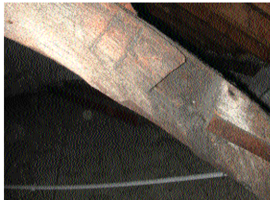
Fig. 8 Entaille d'un mi-bois à queue d'aronde avec sa marque d'assemblage (à gauche sur la photo), sous la forme de deux traits faits à la hache
