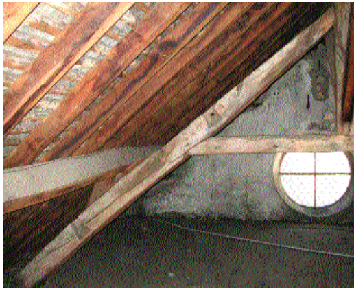
Fig. 8 Entaille d'un mi-bois à queue d'aronde avec sa marque d'assemblage (à gauche sur la photo), sous la forme de deux traits faits à la hache
