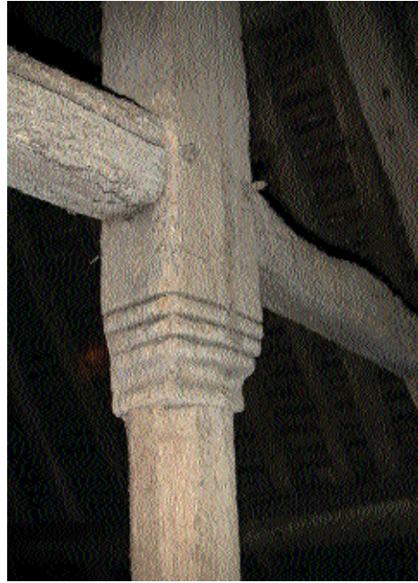
Fig. 7 Moulures du poinçon de la ferme principale.
