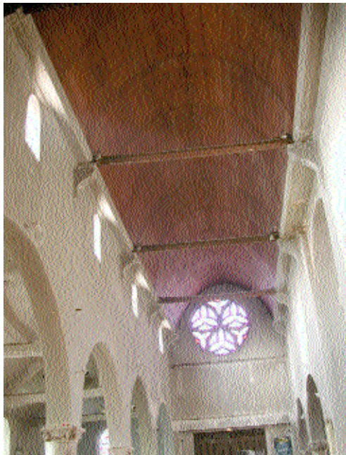
Fig. 6 Charpente voûtée lambrissée de la nef.
