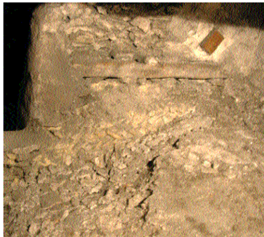
Fig. 14 Maçonneries romanes en opus spicatum du transept avec vue d'une sablière primitive abandonnée en haut du mur, prise dans les adjonctions postérieures.
