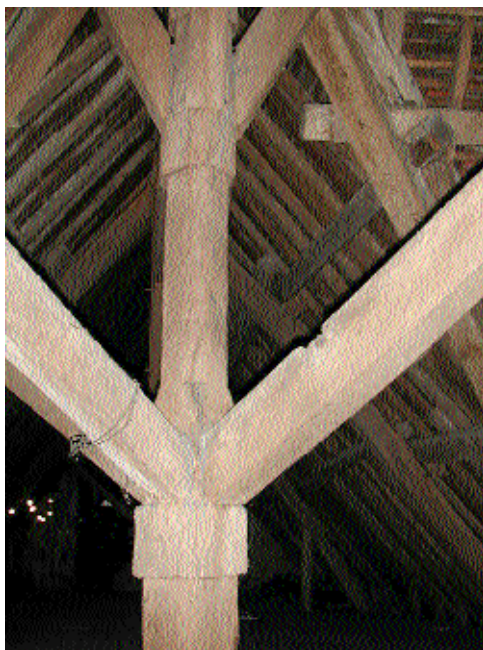
Fig. 13 Fût chanfreiné du poinçon de la croisée avec ses ressauts.
