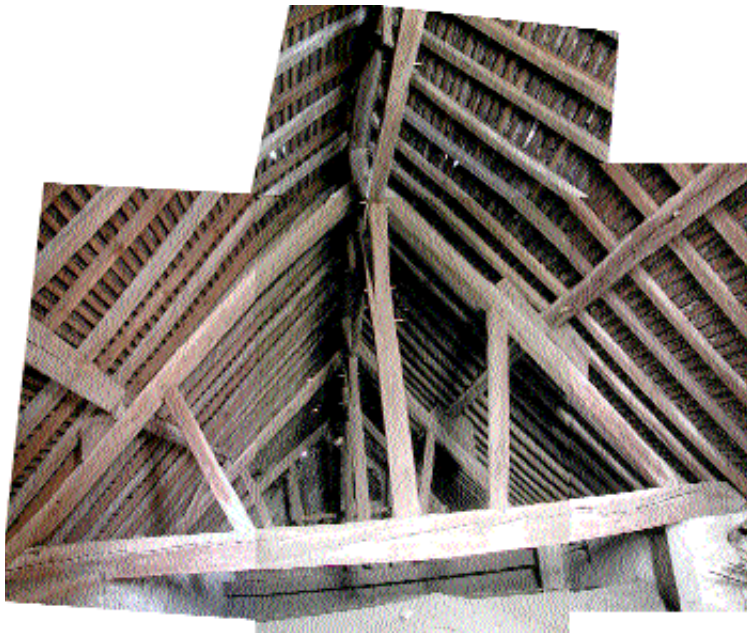
Fig. 3 Charpente du choeur.
