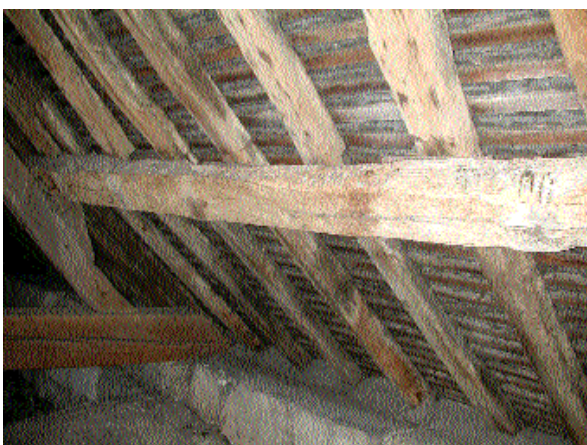
Fig. 13 Négatifs des chevrons d'origine sur la face de la panne retournée
