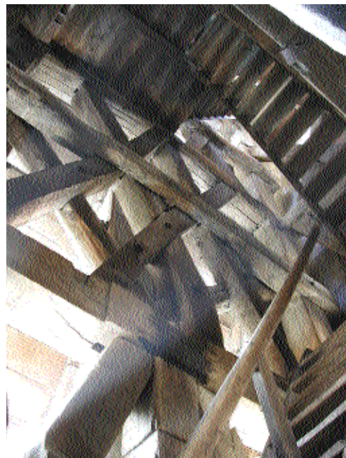
Fig. 10 Pan de bois nord, longitudinal à la deuxième chambre, avec ses écharpes entrecroisées, maintenues en partie haute par des moises boulonnées.
