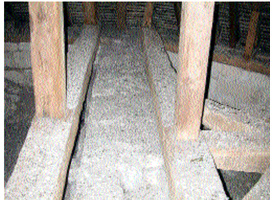
Fig. 11 Arasement de l'ancien mur pignon avec à gauche la dernière ferme de la charpente du XIII e siècle, et à droit la croupe rajoutée au XVI e siècle.
