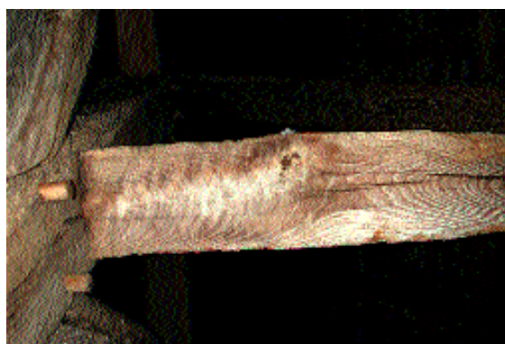
Fig. 25 Lignage à double traits tracés au noir de charbon.
