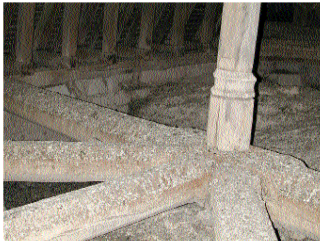
Fig. 15 Enrayure des entrails assemblés dans la ferme de croupe. Pied de poinçon sculpté.
