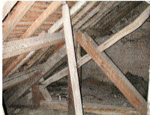
Fig. 4 Charpente en appentis des chapelles latérales nord.
