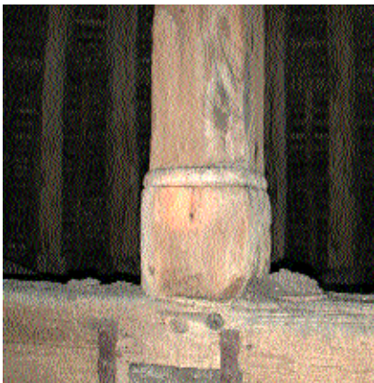
Fig. 7 Moulure de la base du poinçon de la ferme de croupe.
