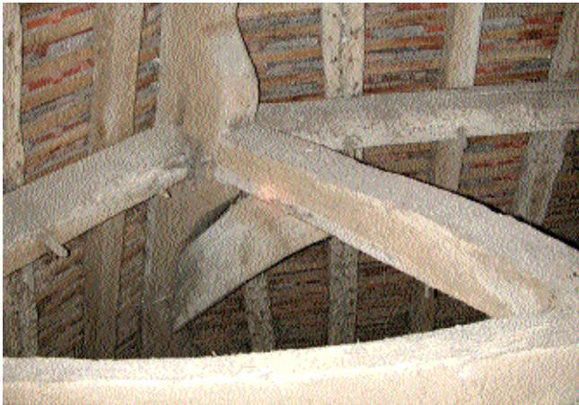
Fig. 10 Demi-ferme d'arêtier de la croupe. L'arbalétrier est surépaissi pour l'assemblage des pannes et de l'entrait retroussé.
